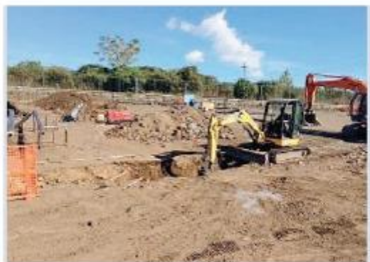
UNA FASE DI LAVORAZIONE DEL CANTIERE
