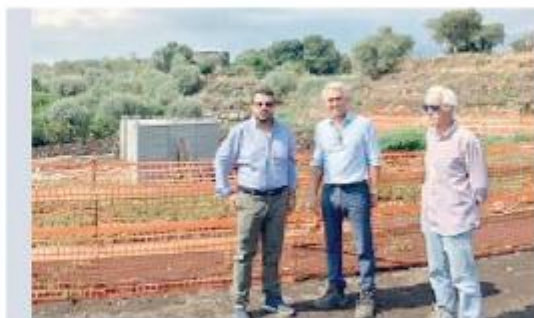
Apertura del cantiere con Simone Rau e il sindaco Salvatore Greco (a sx)
